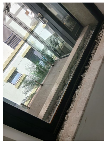
Foto 12.3 Nível Segundo Pavimento Local: Escada
