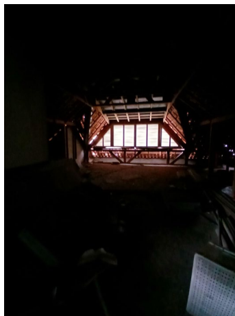
Foto 18.3 Nível Cobertura Local: Sótão
