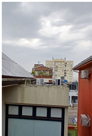
Foto 10.2 Nível Segundo Pavimento Local: Terraço
