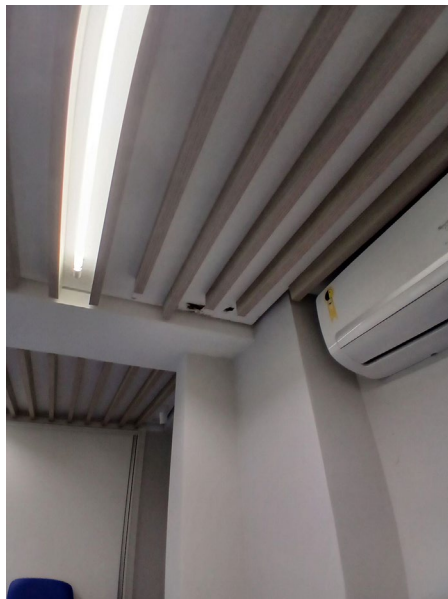
Foto 15.1 Nível Segundo Pavimento Local: Plenária
