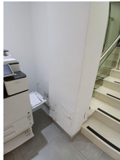
Foto 1.3 Nível Térreo Local: Circulação
