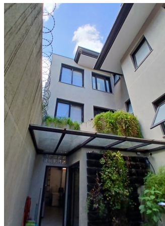
Foto 10.3 Nível Térreo Local: Canteiro acima Lavanderia
