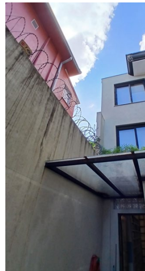
Foto 5.8 Nível Subsolo Local: Muro lateral
