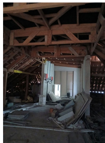
Foto 18.4 Nível Cobertura Local: Sótão
