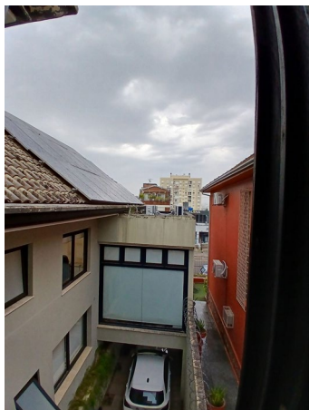
Foto 10.1 Nível Segundo Pavimento Local: Terraço
