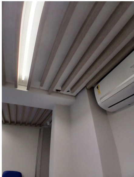
Foto 13.1 Nível Segundo Pavimento Local: Plenária
