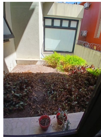
Foto 10.4 Nível Térreo Local: Canteiro acima Lavanderia
