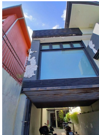
Foto 4.3 Nível Subsolo Local: Fachada frontal
