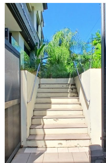
Foto 12.4 Nível Térreo Local: Escada de acesso
